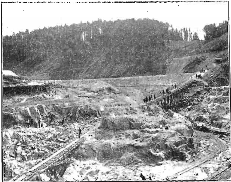
Budowa zbiornika w Mauer.
