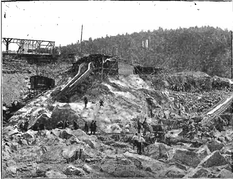
Budowa zbiornika w Mauer.
