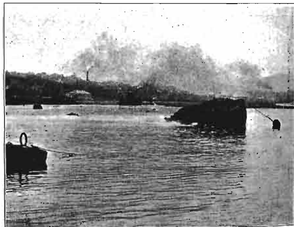
Łódź transportowa, wyładowująca samoczynnie 100 m 3 kamienia w murze. Fot. Wł. Martini.
