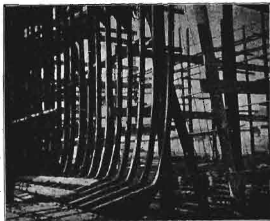
Żebra okrętu budowanego w arsenale austr. Lloyda w Tryeście. Fot. W. Łuczaków.
