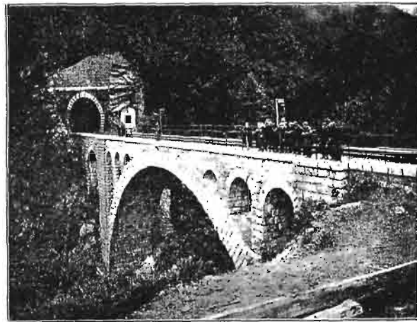
Wiadukt przez Vintgar (Rotweinklamm) o rozp. 41 m. Fot. W. Martini.
