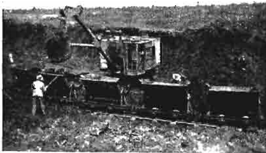
Rys. 4b. Bagier przy pracy w Seeshaupt.
