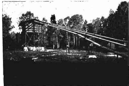
Rys. 7b. Widok na ładownię. Seeshaupt.
