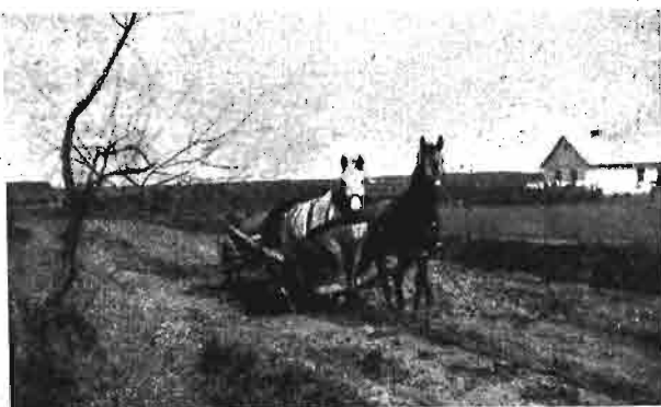
Rys. 4. Tak wygląda większość naszych 270 000 km dróg gruntowych.
