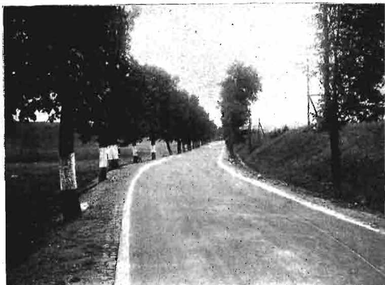
Rys. 2. Droga o nawierzchni ulepszonej — takich dróg posiadamy ok. 3 000 km.
