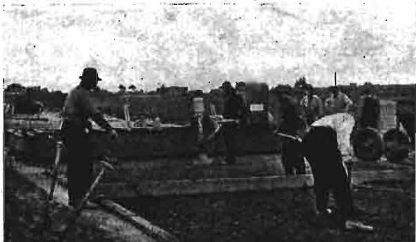
Rys. 4. Na pierwszym planie — rozplanowywanie mieszanki według szablonów; na drugim planie — ubijanie rozplanowanej mieszanki.
