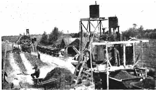
Rys. 1. Plac mieszania; na pierwszym planie — mieszarka.
