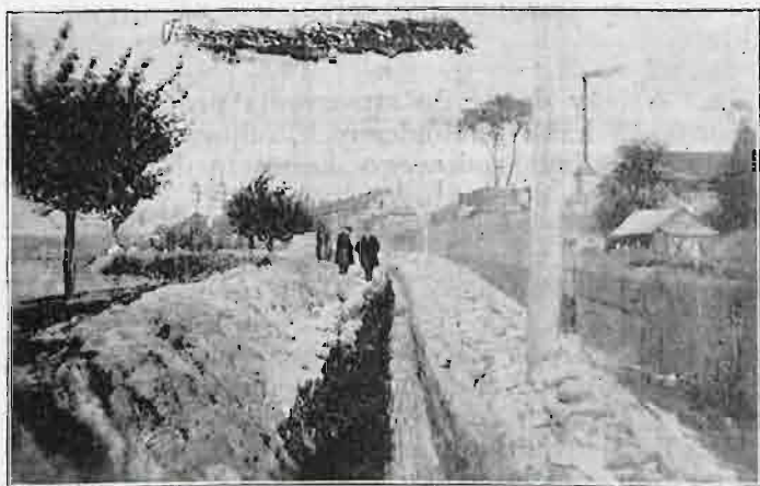
Układanie kabla.
