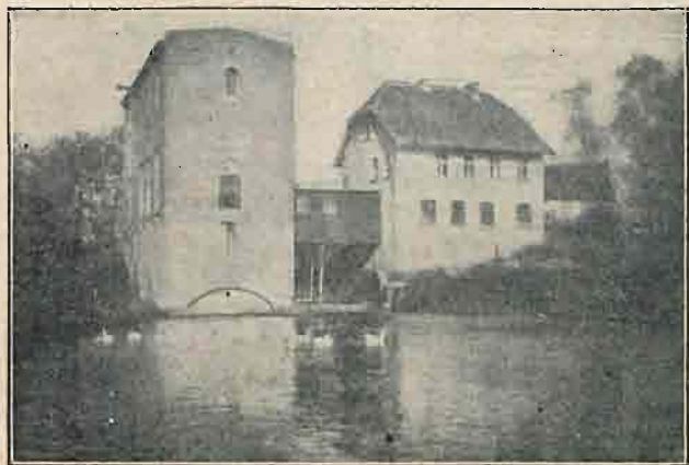
Rys. 9. Zakład wodno elektryczny w Owidzu (widok od strony wody dolnej).
