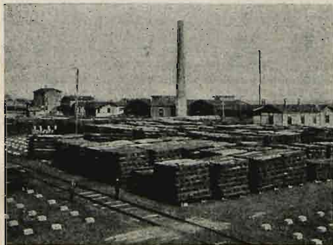
Rys. 3. Składowisko podkładów nasycanych (Zadwórze). Białe plamki to kłocze betonowe, na których układa się podkłady aby nie dotykały ziemi.
