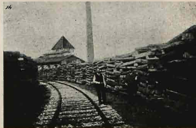
Rys. 2. Przewiewne układanie podkładów na stopy na składowisku zakładu impregnacyjnego przed ich naparzeniem. (Dziedzice).
