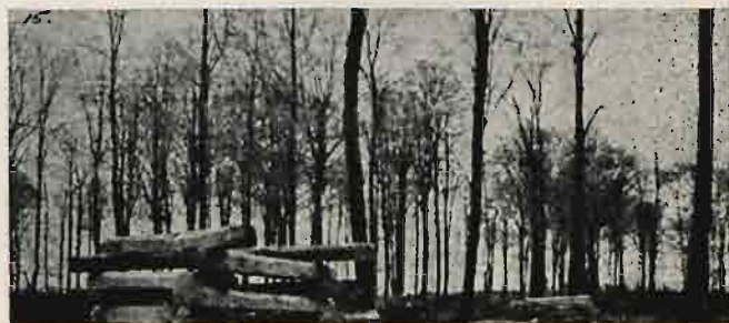
Rys. 1. Przewiewne układanie w niewielkie stopy, podkładów świeżo wyrobionych, po lesie przed ich wywiezieniem na składowisko do zakładu impregnacyjnego.
