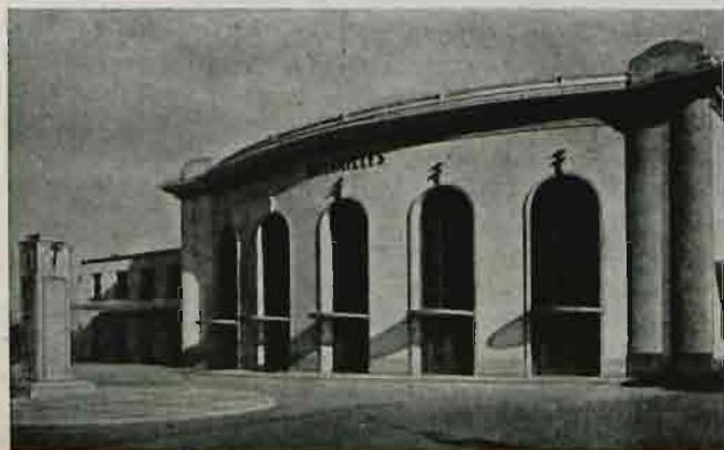
Dworzec na st. Versailles-Chantiers
