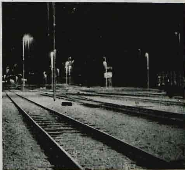
— Rys. 1. Stacja rozrządowa oświetlona lampami sodowymi, zawieszonymi na słupach wysokości 10 do 15 metrów.
