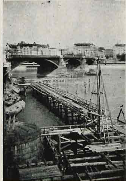
Rys. 8. Przebudowa mostu Małgorzaty.
