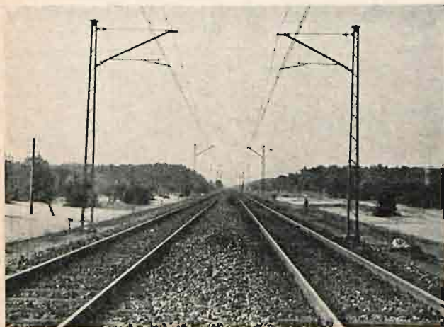
Rys. 4. Ogólny widok sieci trakcyjnej.
