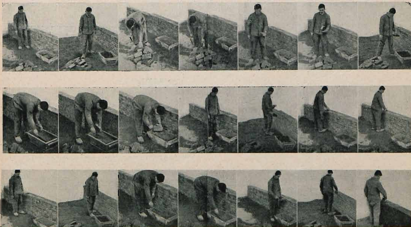
Rys. 15. Praca murarza przy zastosowaniu rusztowań stałych.
