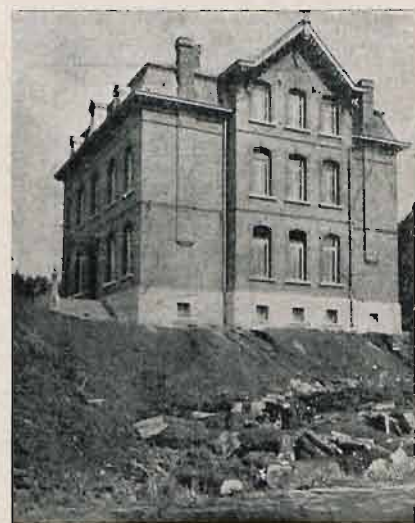
5 września. Roboty są ukończone, budynek podniesiono o 3.60 m, schody są ponownie ustawione.
