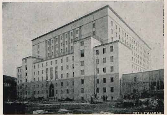
Rys. 8. Stan robót dnia 1.10.29 r.
