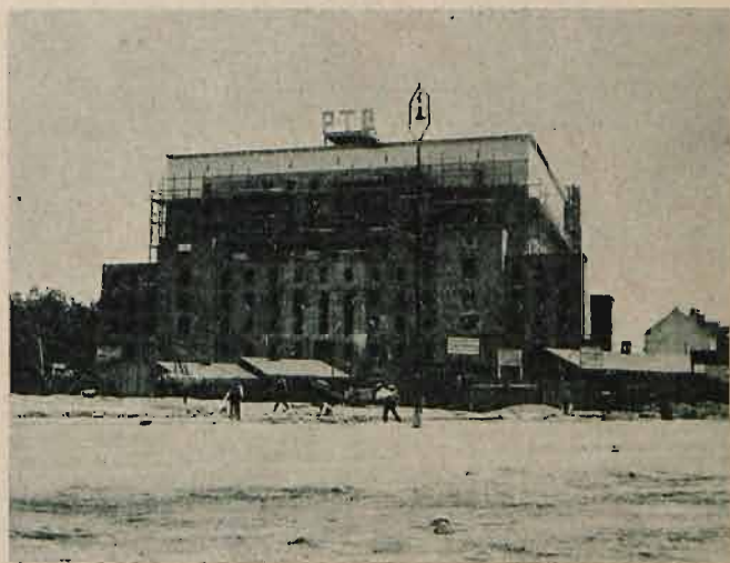
Rys. 7. Stan robót w czerwcu 1928 r.
