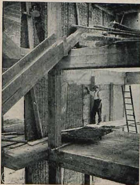
Fragment ustawiania płyt z Solomitu w ścianach zewnętrznych hotelu Biarritz.
