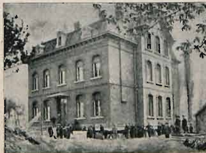
30 maja. Rozpoczęcie robót, lewary pracują, usunięto schody dla ułatwienia pracy.
