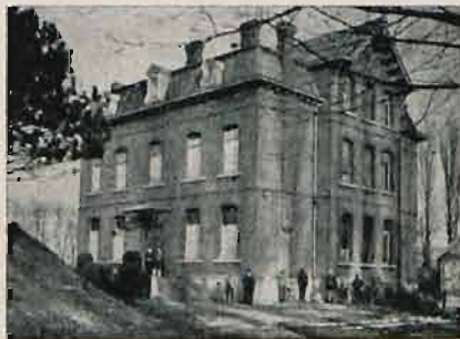
Kwiecień 1929. Dom w stanie pierwotnym. Nasyp z lewej strony wskazuje przyszły poziom domu. Prowadzi się rozbiórki piwnic dla wstawienia lewarów.
