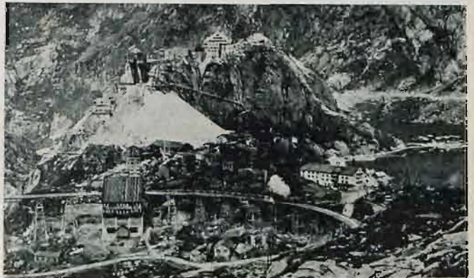
Fig. 6. Ogólny widok miejsca robót.
