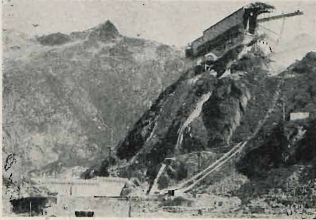
Fig. 11. Spitallamm. Budowa zapory. U góry sortownia i fabryka betonu.
