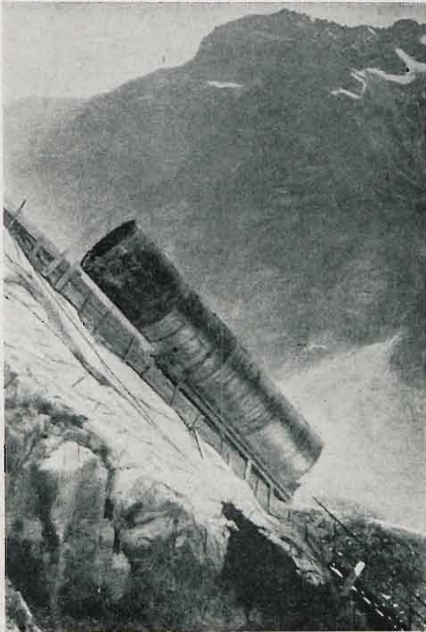
Fig. 5. Transport rury dla sztolni ciśnącej wagi 9 t.
