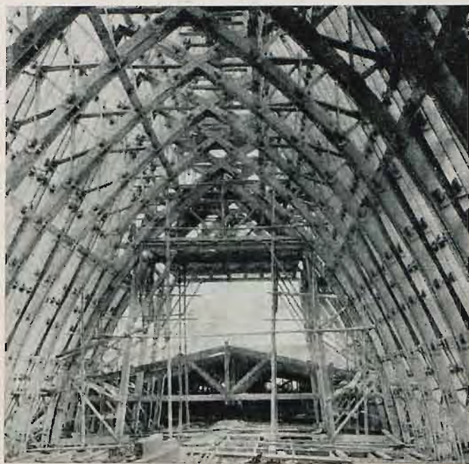
Rys. 2. Wiązary z gotowych elementów w odbudowanej katedrze w Reims.
