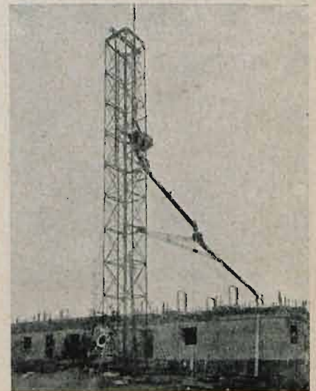
Dom z betonu porożyłowego w budowie.
