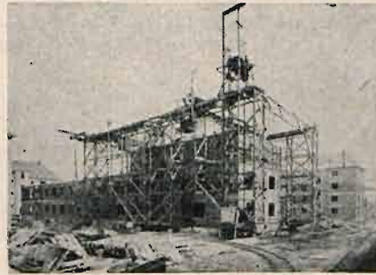
Dom z betonu żużlowego w budowie.
