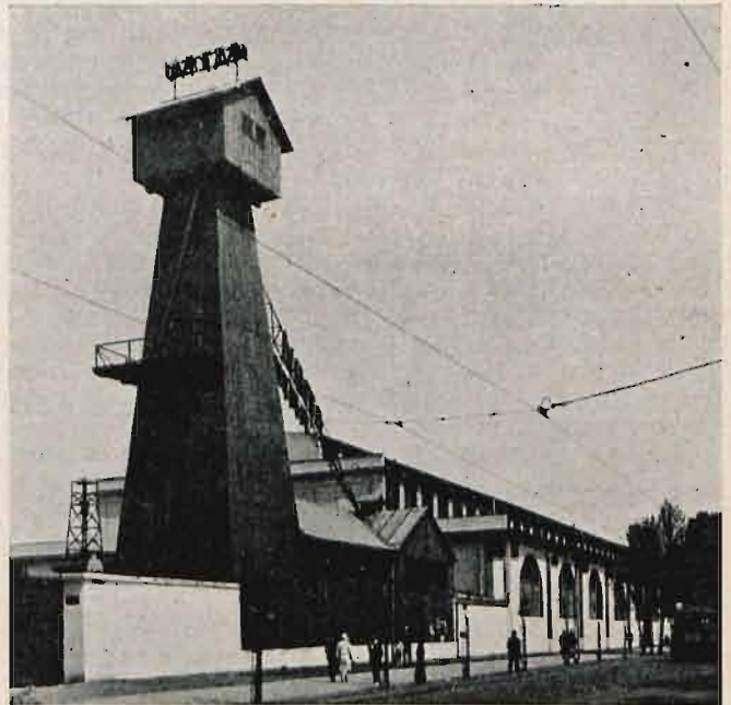
Budowę wykonało przedsiębiorstwo robót inżynieryjno-budowlanych Zygmunt Schnotale w Poznaniu.
