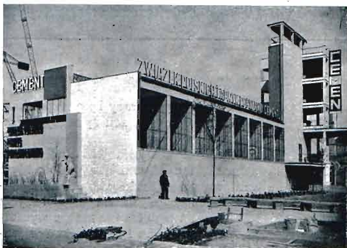
Pawilon Przemysłu Cementowego. Dzieło arch. Lacherta i Szanajcy.
