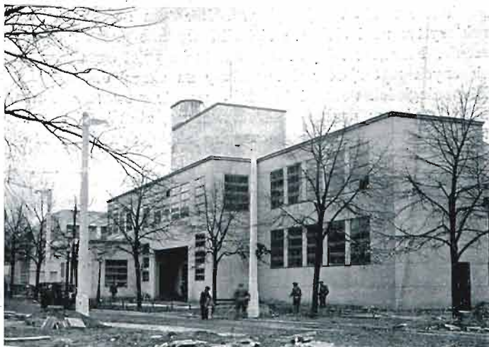
Pawilon Min. Pocht i Telegr. Do budowy zużyto 9000 m 3 „Celotexu”.
