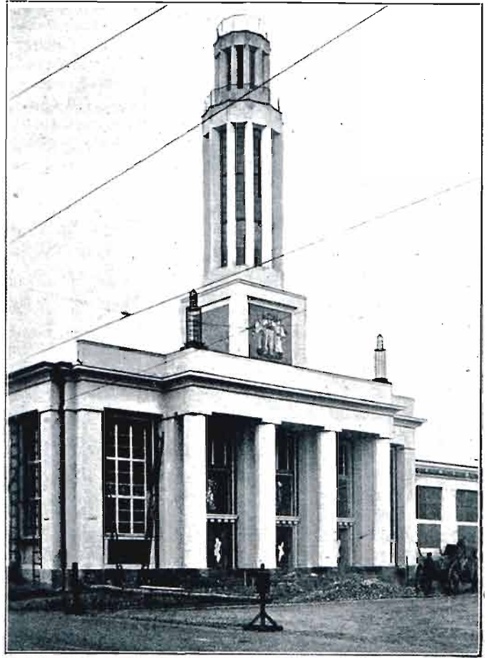
Westibul. Konstr. żelbetowe, wyk. firma „Inż. Bzyl“ w Poznaniu, posadzki cementowe i studzienki, wyk. firma „Kerament Polski“ w Poznaniu.
