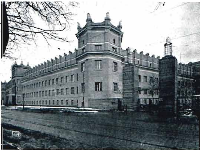
Pałac Rządowy na P. W. K. Roboty żelbetowe wyk. firma Inż. A. Bzyl w Poznaniu, roboty ziemne i niwelacyjne i asfaltowanie ulic na terenie pałacu wyk. firma „Kocent i Goździewicz“ w Poznaniu, roboty ciesielskie firma „Jan Domeracki“ w Poznaniu.
