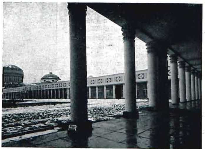
Hala centralna na P. W. K. Ustroje żelbetowe, kolumny i attyki wyk. firma inż. A. Bzyl w Poznaniu. Posadzki cementowe, płytki glazur. i studzienki wyk. firma „Kerament Polski“ w Poznaniu, chodnik w podziemiach wyk. „Kocent i Goździewicz“ w Poznaniu.
