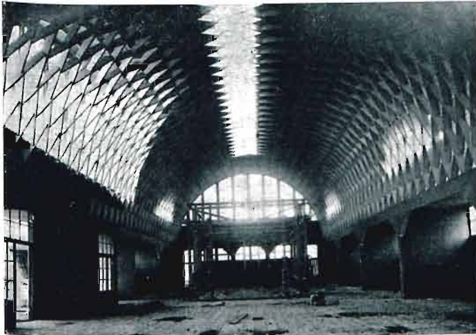
Wnętrze pawilonu „Przemysł Budowlany“ w trakcie budowy.
