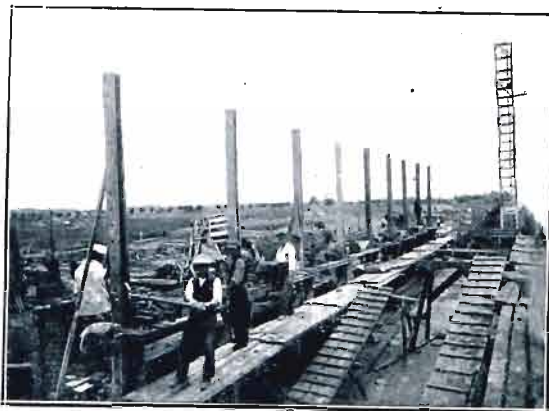
Budowa Fabryki Tkanin Sztucznych w Chodakowie.
