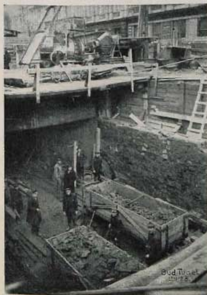
Fot. z dn. 11.I.1928. Niepokryta część tunelu na odcinku Błocka—Marszałkowska dla zsypania ziemi wywożonej tunelem.
