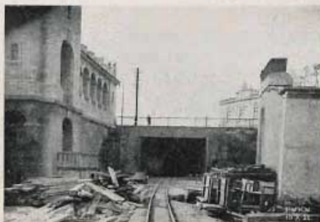
Fot. z dn. 10.X.1928. Wylot wykonanego tunelu przy ul. Smolnej.
