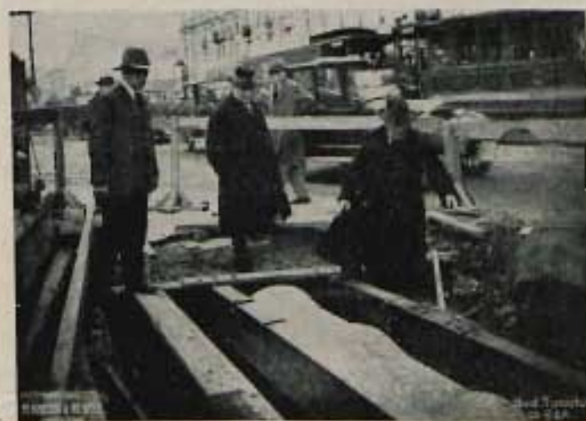
Fot. z dn. 10.X.1928. Konstrukcja odciążająca pod ul. Marszałkowską w miejscu przecięcia się z przewodem kabli telefonicznych.
