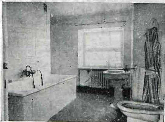
465. Łazienka na piętrze.
