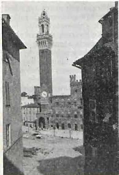
217. Wieża ratuszowa w Sienie. Piękny przykład średniowiecznego wycucia architektury. Wskutek rozszerzenia baszty ku górze wspomniane przez nas dalej złudzenie Zöllnera stwarza entazis ścian bocznych, co z kolei usuwa przykrą dla oka ich prostolinijność.
