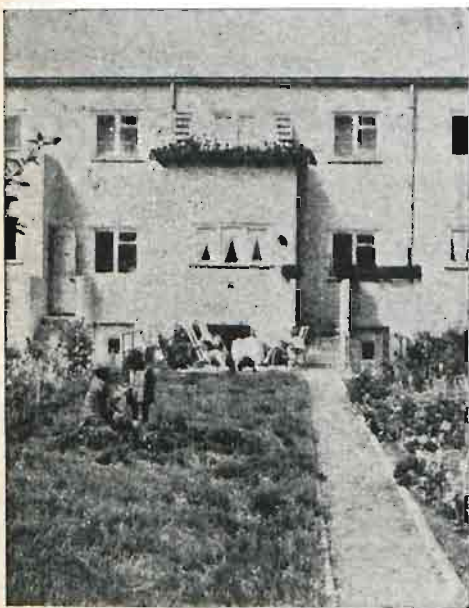
187. Dom jednorodzinny bez komina w osiedlu Neudorf.
