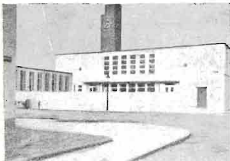
184. Zdjęcie centralnego budynku.
