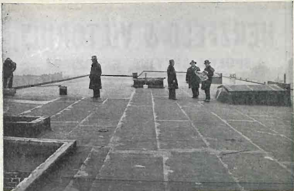
Krycie „Trocalem“ dachu gmachu Banku Gospodarstwa Krajowego, Warszawa — Al. Jerozolimskie nr. 1.
