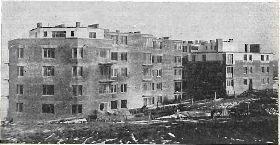
87. Dom przy ul. Spacerowej w budowie.
