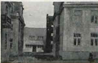
53. przewietrzane przez luki wentylacyjne, wychodzące niestety na ścianę sąsiada.
