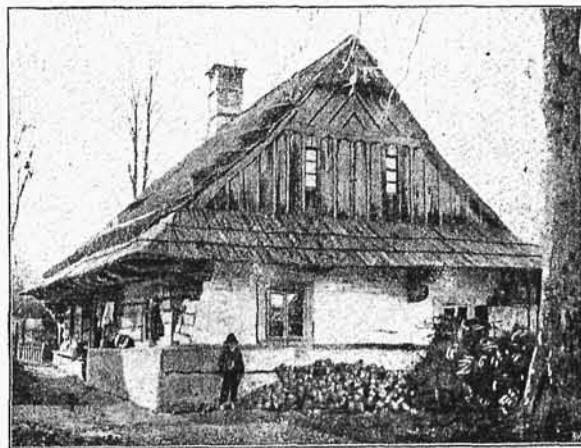
Rys. 11. Śląsk Austriacki, dom w Trzyciezu z r. 1801 ze szczytem i daszkiem przyźbowym. (Glogier. Budown. drzewne).
