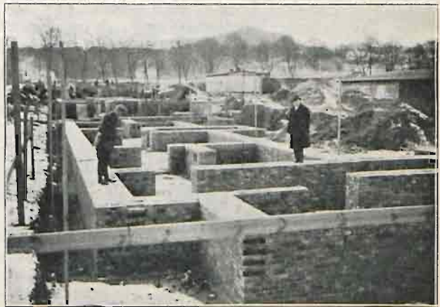
2. Budowa w Gdyni.
