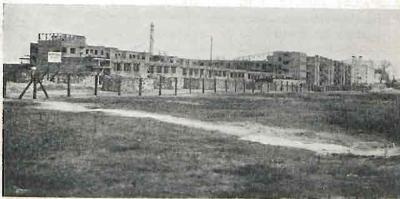
38. Ogólny widok na blok budujących się domów Warszawskiej Spółdzielni Mieszkaniowej na Żoliborzu.
