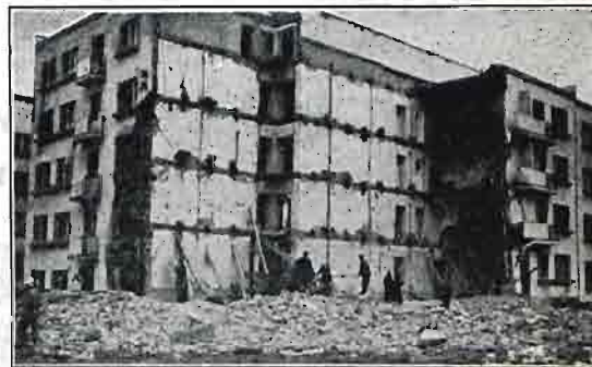
rys. 563. Drzwi wejściowe oznaczone krzyżykami wypchnięte prężnością gazów uwidocznione na rys. 564 Część muru frontowego (xx) trzyma się ściany wewnętrznej wyłącznie spójnością muru. Wspomniany mur w większej skali widzimy na rys 565
