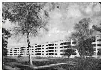
Część bloku w osiedlu „Siemens- stadt“
