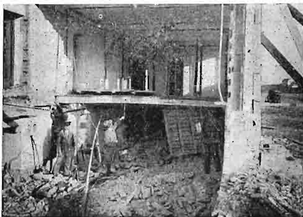
rys. 561 Belka dwuteowa Nr. 22, wygięta do góry 5 cm.
