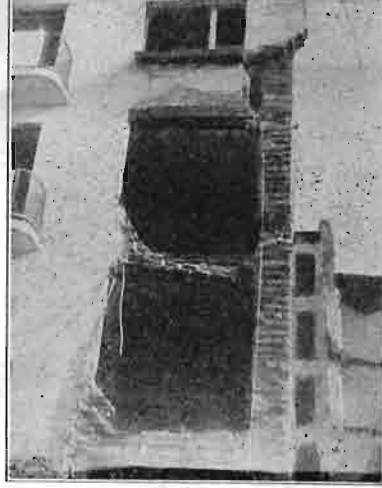
rys. 565. Mur trzyma się ściany wewnętrznej spółności murów.
