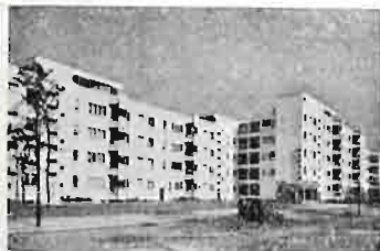
Część bloku w osiedlu „Siemens- stadt“
