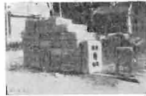
rys. 515 przewody kominowe z gazobetonu
