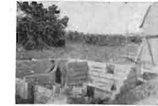
rys. 514 piwnice z bloków gazobetonow.
