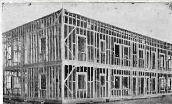
rys. 476. Z książki Neutry „Ameryka“ dom drewniany w 2-gim dniu montowania
