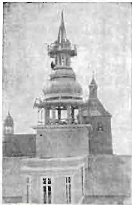
Budowa wieży na ratuszu.
