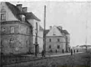
rys. 245. Miejska Kolonia Urzędnicza przy ul. Nowomiejskiej we Włocławku
