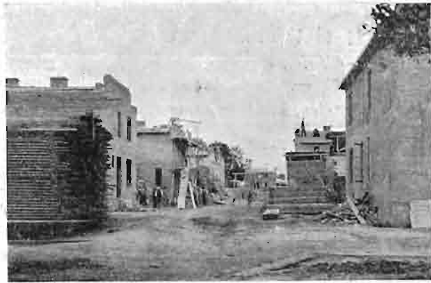
rys. 249. Osiedle robotnicze z betonu żuźlowego pod Łodzią w czasie budowy.
