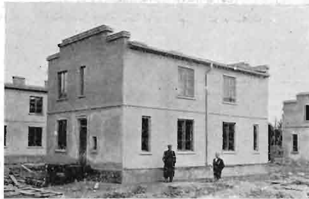
rys. 250. Dom robotniczy pod Łodzią z żuźlobetonu.
