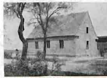
rys. 158 Dom mieszkalny mrowany pod dachówką, stodoła drewniana pod papą Budowa ukończ. 1930
