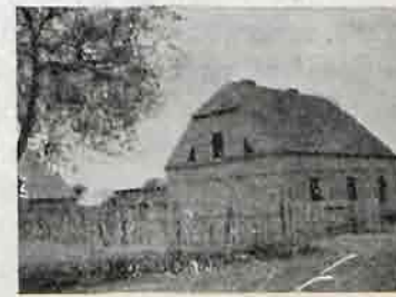
rys. 159 Dom mieszkalny mrowany kryty dachówką i stodoła drewniana pod dachówką. Budowa ukończona w 1927 r.
