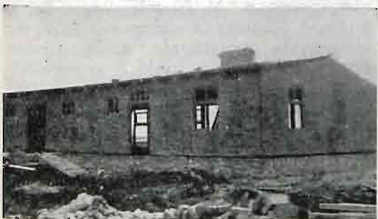
rys. 207 Ściany obite „Solomitu”
