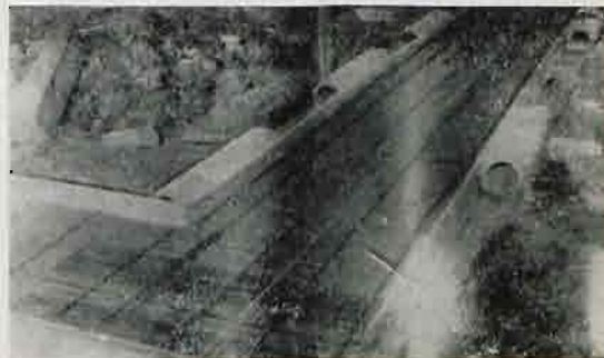
rys. 204 Zkrojenie płyty żel-betowej pod podmurówkę z cegły (ponieważ budynek wznosi się na torfowisku płyty betonowe ma'ą chronić przed zapadaniem).
