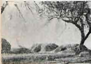
rys. 152 Lepianki w osadzie Targowej przed rozpoczęciem akcji budowlanej.
