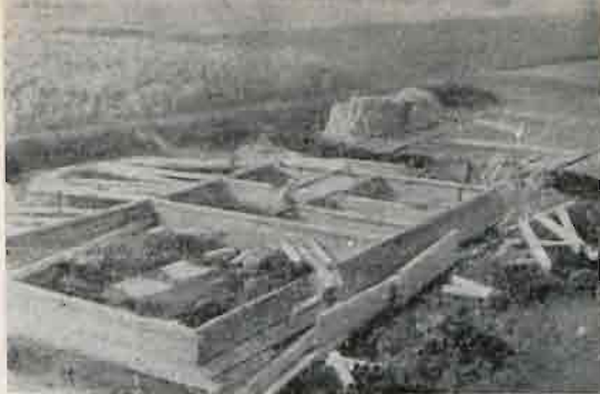
rys. 205 Wiktorowo. Widok fundamentów pod budynek z Solomitu
