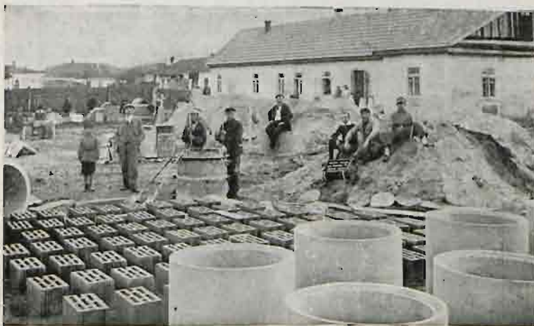
Jedna z licznych betoniarni wiejskich założona na Kresach Wschodnich na skutek propagandy Związku Polskich Fabryk Portland-Cementu.
