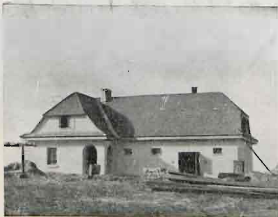
rys. 184. Budynek mieszkalno-gospodarczy glinobity; osada Budy
