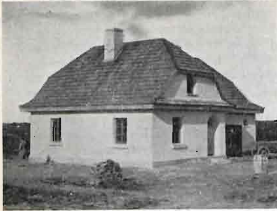
rys. 185 Budynek glinobity, osada Budy (P. B. R. w Wilnie)
