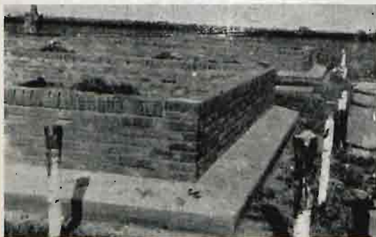
rys. 203 podmurówka z cegły na płytach betonowych
