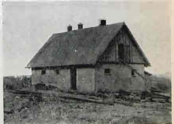
rys. 189 Chlew glinobity pod strzechą glinosłonią na osadz. Budy
