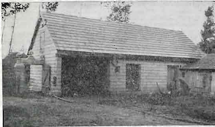
rys. 223. Stajnia, obora i wozownia w budynku z pustaków.
