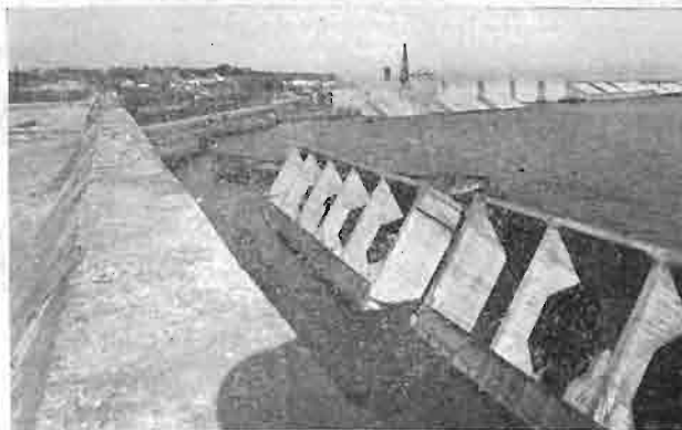
Skrzyńce żelbetowe przy budowie portu w Gdyni
