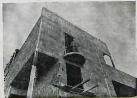
28 Ściana zewnętrzna. Zamurowane w niej słupy owinięto drutem dla ułatwienia wyprawy.
