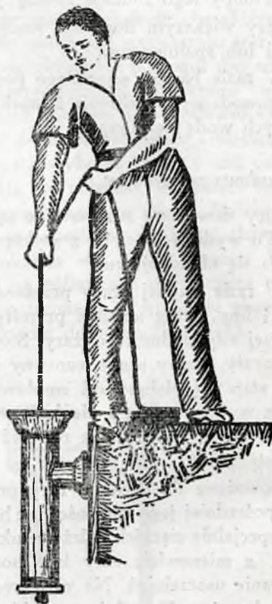
Rys. 275. Opuszczanie kształtek wodociągowych do wykopu.
