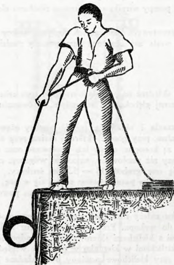
Rys. 274. Opuszczanie rur mniejszej średnicy do wykopu.
