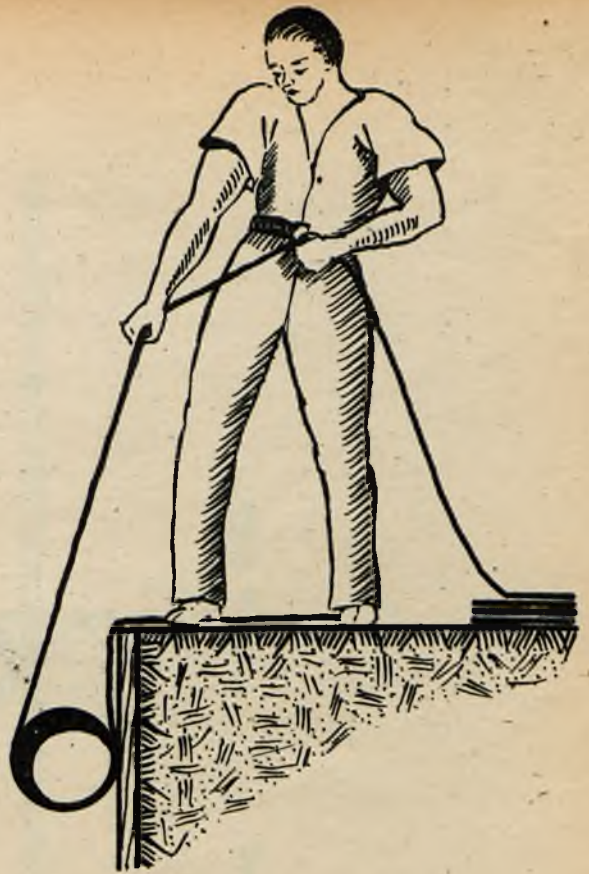
Opuszczanie rur mniejszej średnicy do wykopu.
