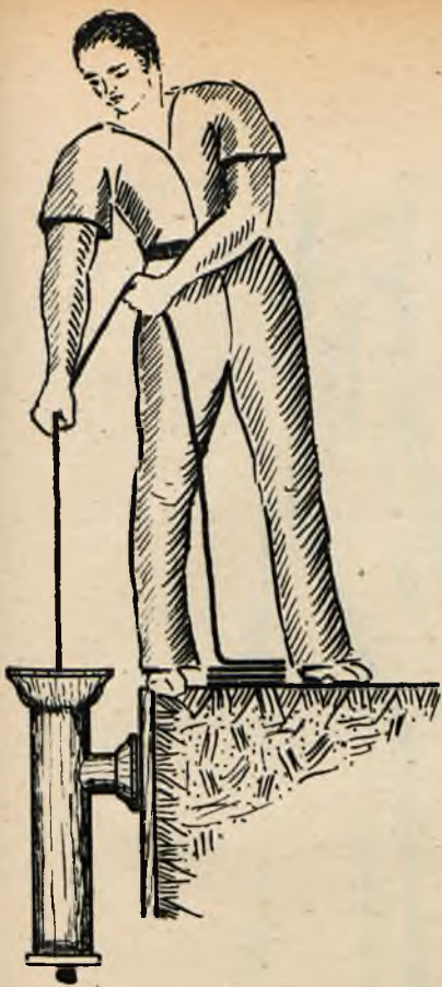
Opuszczanie kształtek wodociągowych do wykopu.
