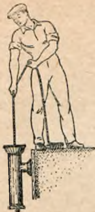
Rys. 241. Opuszczanie kształtek wodociągowych do wykopu
