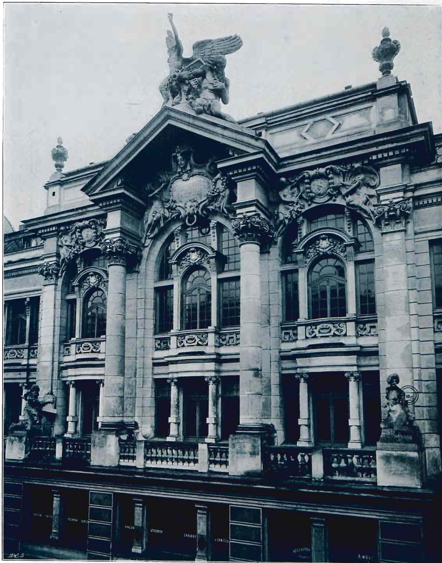
GMACH STOWARZYSZENIA TECHNIKÓW W WARSZAWIE, PRZY UL. WŁODZIMIERSKIEJ 3—5. SZCZEGÓŁ LICIA GŁÓWNEGO.
