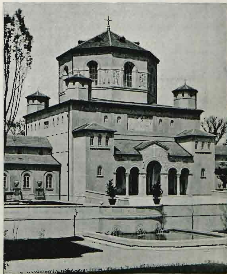
Rys. 5. Monachium. Gmach administracyjny na cmentarzu północnym.
