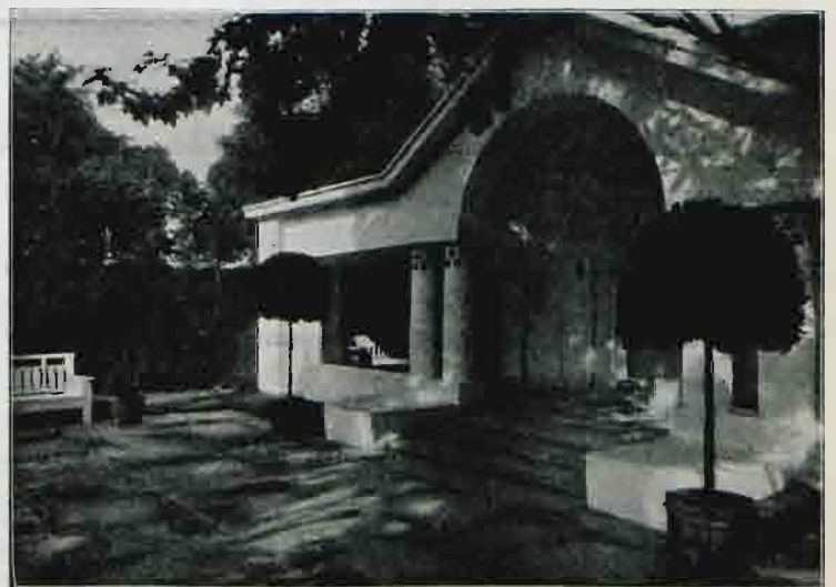
Rys. 8. Wejście do kąpieli w ogrodzie.
