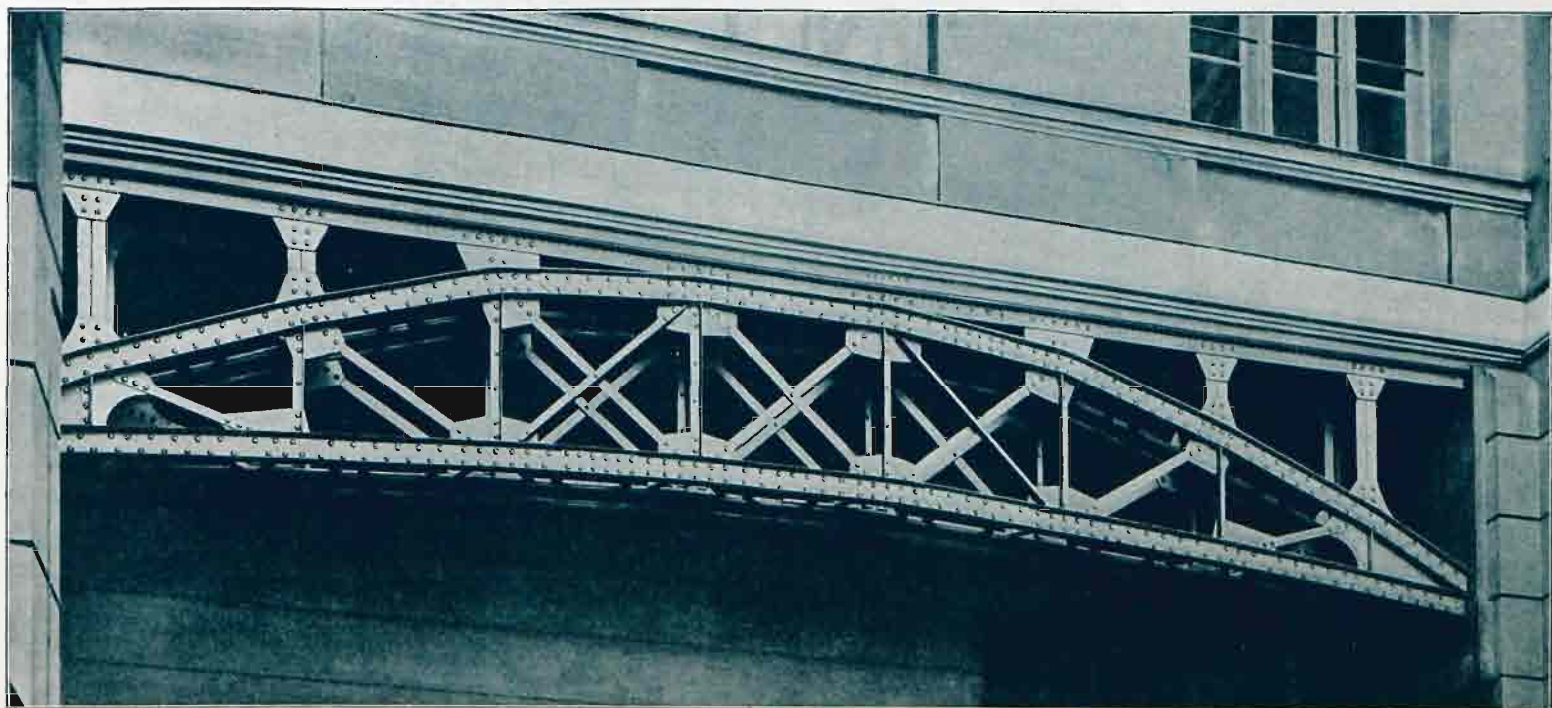
Rys. 14. Dźwigar pod murem zewnętrznym klatki schodowej.
