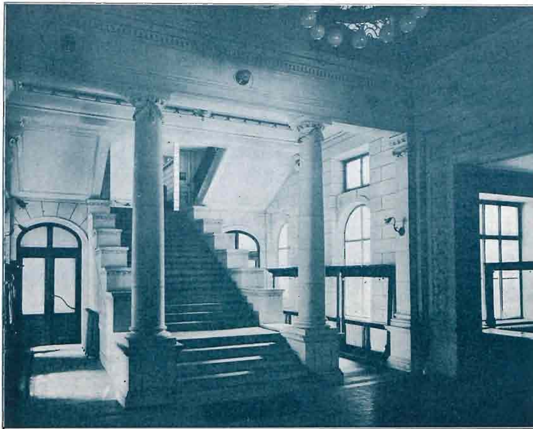
Rys. 6. Westybul i schody główne.
