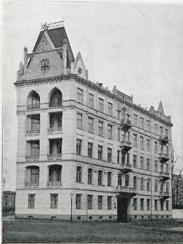
Rys. 1. Lice domu Nr. 1 od ul. Wielkiej.
