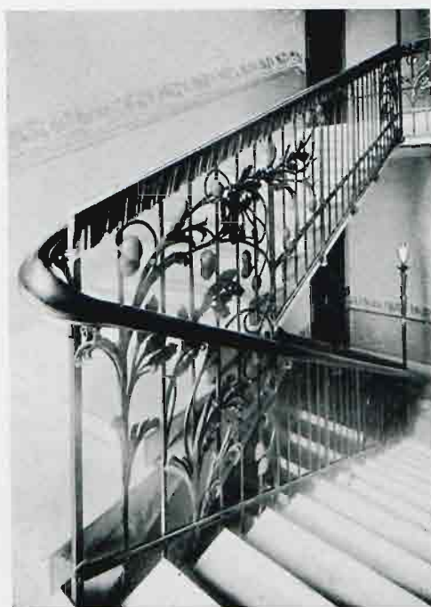
Balustrada na schodach głównych.
