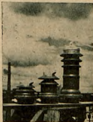
Rys. 162. Ochronniki fir. K. Szpotański na 3 — 6 i 15 kV.
