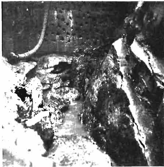
Rys. 4. Uskok skalny w fundamencie.
