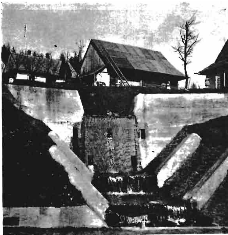
Rys. 3. Ujęcie wody dla żłobu na potoku „Suchym”
