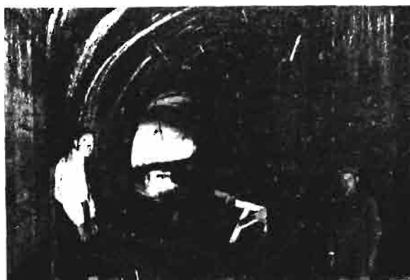
Rys. 18. Segment sztolni obiegowej.
