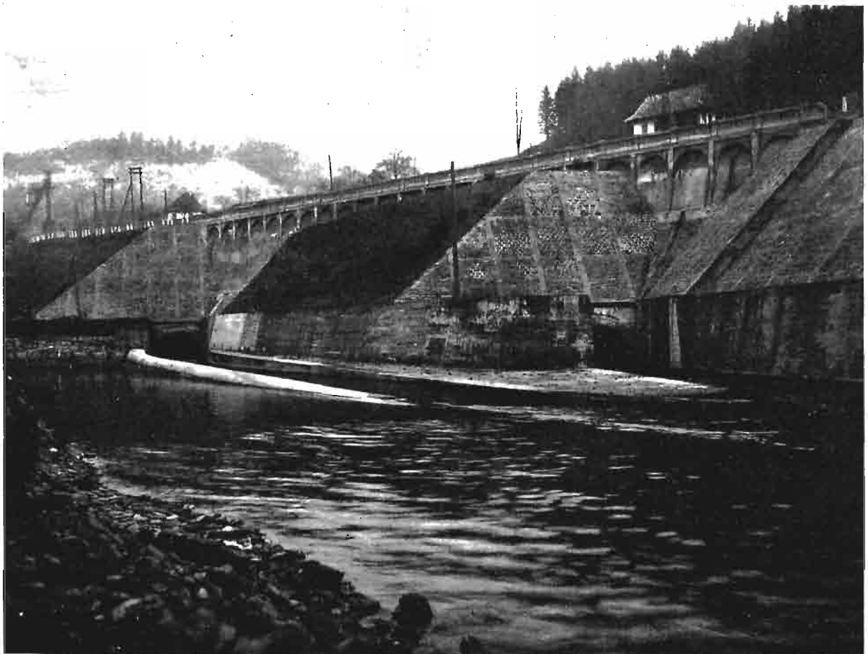
Wyloty sztolni obiegowych.
