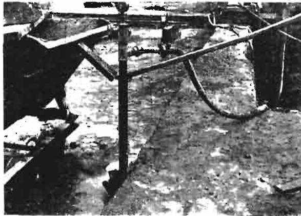
Rys. 6. Aparat zastrzykowy z manometrem.
