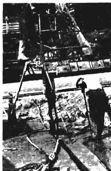
Rys. 12. Wiercenie otworu systemem „Ingersoll”.
