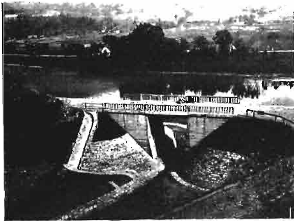
Rys. 24. Most na potoku Basioraczka.
