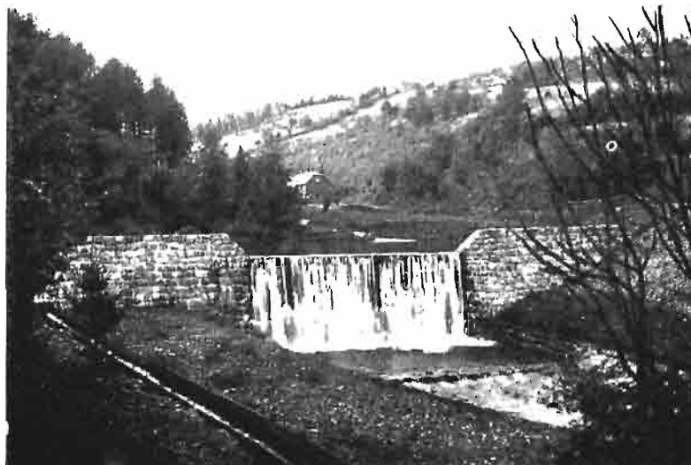
Rys. 4 Zabudowanie potoku Wielka Żarnówka wraz z ujęciem wody do młynówki.
