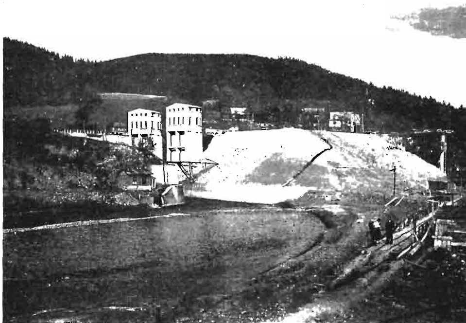
Rys. 17. Widok na wloty do sztolni obiegowych i na wieże zaniknięć.
