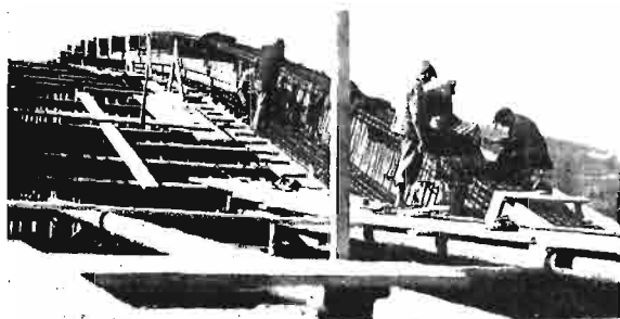
Rys. 16. Zbrojenie łuków.
