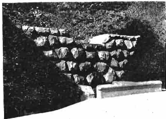
Rys. 2. Jeden ze ścieków, zabudowany zapoiką kamienną. Widoczny na lewo rów tyrolski, odprowadzający wodę do kociołka, wykonanego przy wlocie przepustu.
