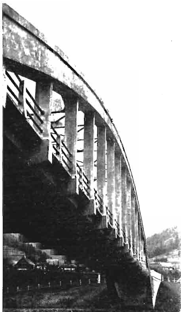
Rys. 22. Most w Tresnej z widokiem na pomost kasetowy.
