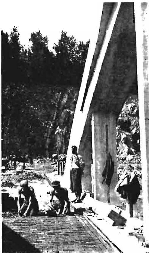
Rys 19. Układanie kostki na jezdni.
