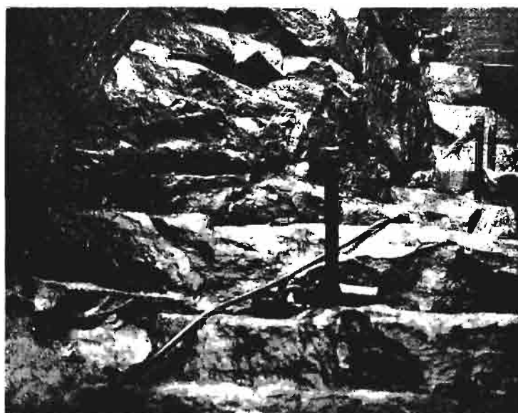
Rys. 21. Widok na ostrogę bloku 9-ego. Widoczne rury zastrzykowe.
