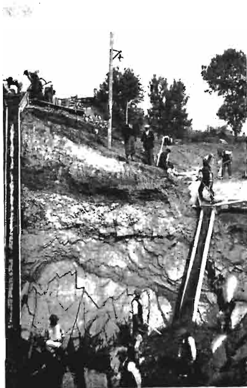
Rys. 13a. Betonowanie lewego bloku podfundamentowego.
