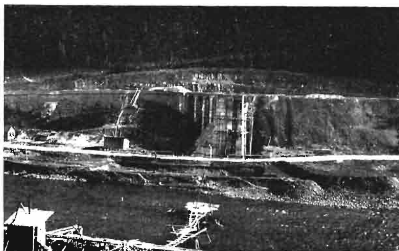
Rys 3. Prawy przyczółek zapory.
