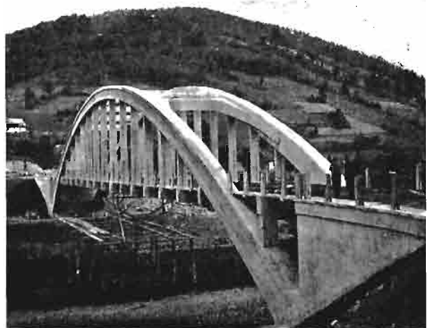
Rys 20. Most po ukończeniu.
