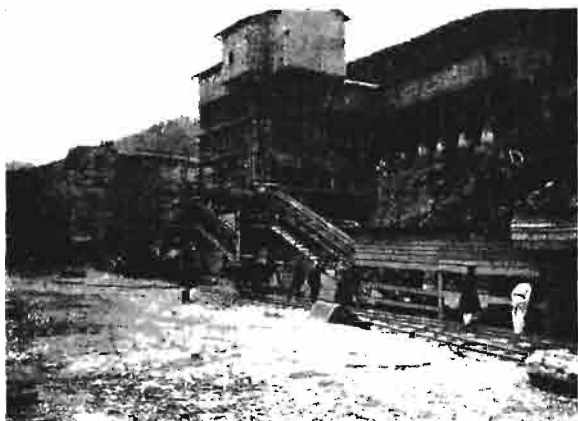
Rys. 11d. Wytwórnia kruszywa i betonu.
