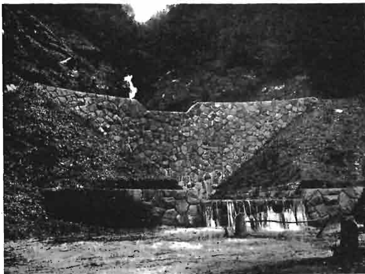
Rys. 2. Zabudowanie debry za pomocą zapory.
