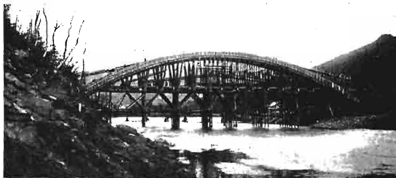
Rys. 17. Witek mostu całkowicie zaszalowanego w chwili betonowania łuków, widoczne pochylenie dla transportu betonu.
