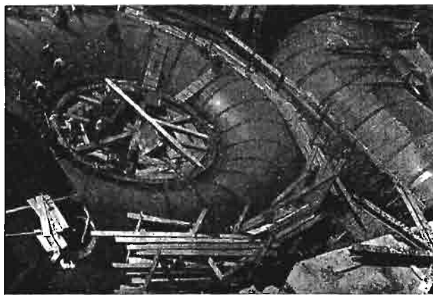
Rys. 21. Montaż spiral turbin.
