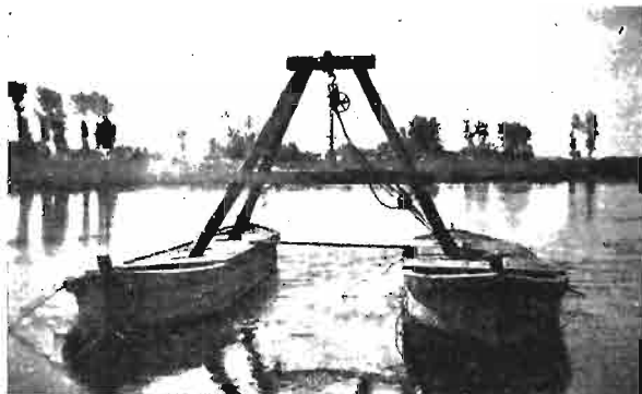
Ryc. 2. Prądówka, używana do czyszczenia koryta Warty.
