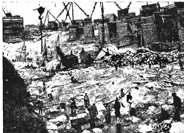
Rys. 15. Roboty ziemne w partii środkowej.
