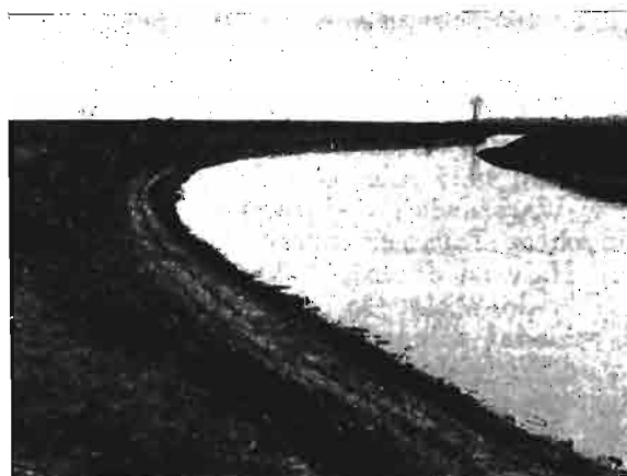
Rys. 8. Przekop Nidy w km 0,050 po zrealizowaniu w 1935 r.
