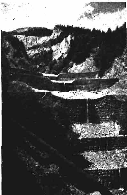
Rys. 1. Szereg zapór, wykonanych dla podniesienia dna potoku.
