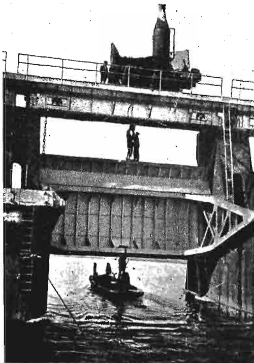
Rys. 5. Próba podnoszenia segmentu Tainter'a.
