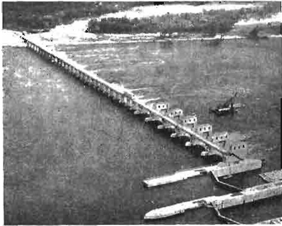
Rys. 4. Jaz po wykończeniu. Na pierwszym planie śluzy komorowe.
