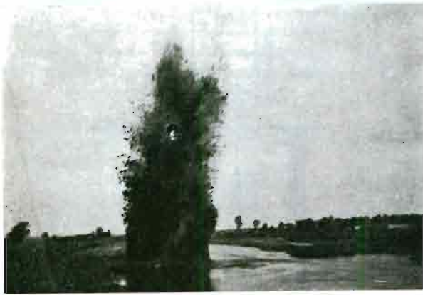
Rys. 7. Poszerzanie przekopu na rz. Horyniu w Komarówce.
