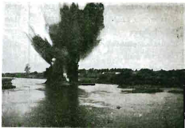
Rys. 6. Poszerzanie przekopu na rz. Horyniu w Komarówce. Wybuch o sile 20 kg prochu.
