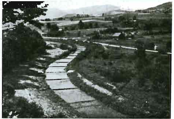
Rys. 9. Zabudowany Smolnik w km. 6+200.
