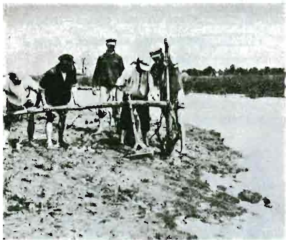
Rys. 5. Wyciąganie rury po założeniu ładunku na rz. Styrze w Połonnem.
