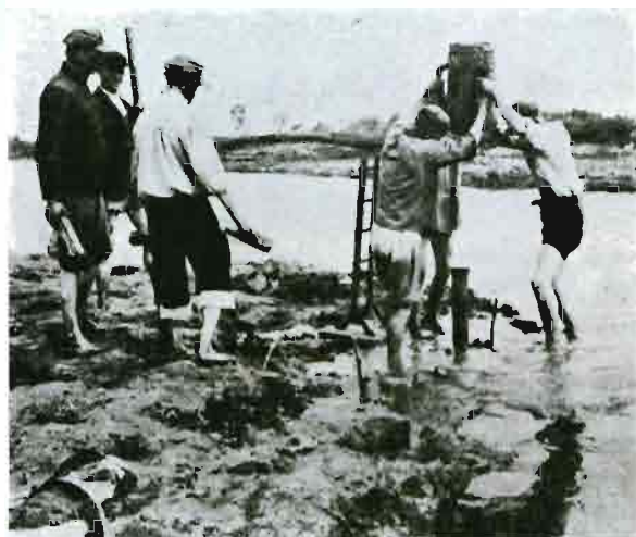
Rys. 3. Fragment wbijania rury do głębokości 2 m na rz. Styrze w Połonnem.
