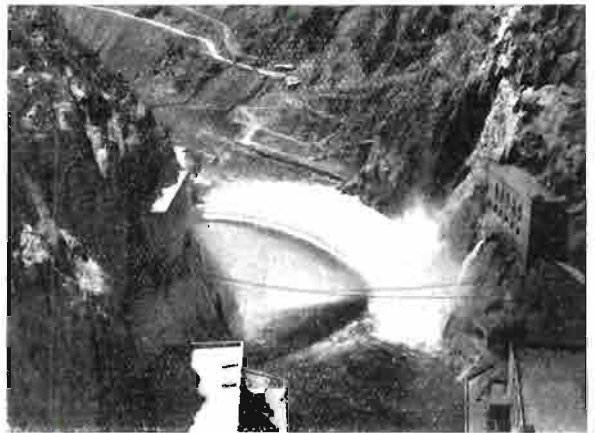
Rys. 35. Widok z korony zapory na zakład i spusty.
