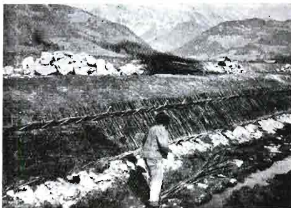
Rys. 6. Brzegosłon faszynowy w chwili zakładania.
