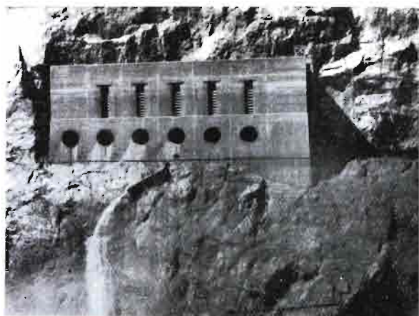
Rys. 33. Budynek zamknięć wypustów prawobrzeżnych.
