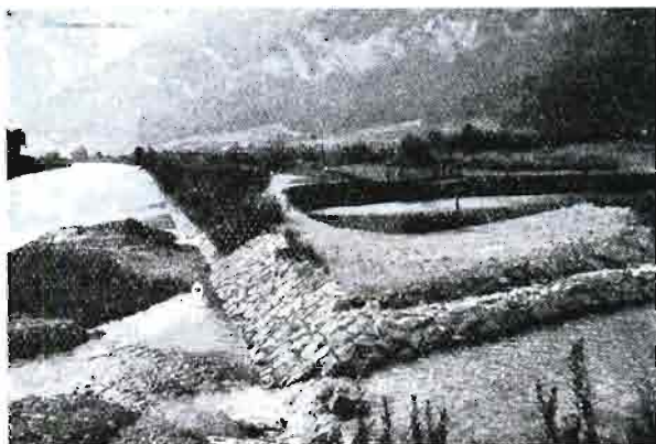
Rys. 8. Brzegosłon faszynowy w 4 miesiące po założeniu.
