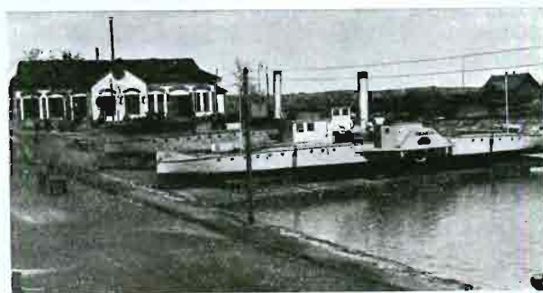
Rys. 6. Widok na stocznice i budynek warsztatowy.
