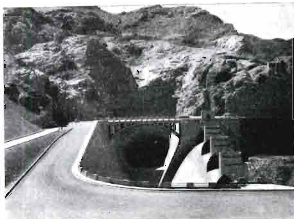
Rys. 28. Wlot do sztolni obiegowej przy przelewie lewobrzeżnym.
