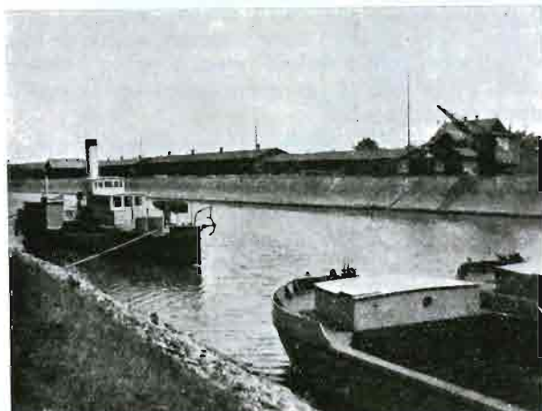
Rys. 4. Widok na port od strony kanału wjazdowego.
