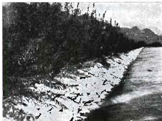
Rys. 7. Brzegosłon faszynowy w 4 miesiące po założeniu.
